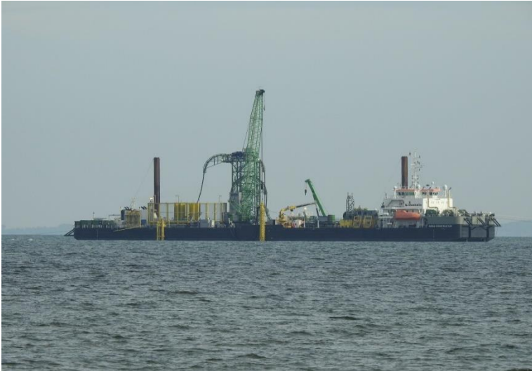
Abb. 5: Kabelverleger im strandnahen Bereich vor Freesendorf, 01.06.2021.
