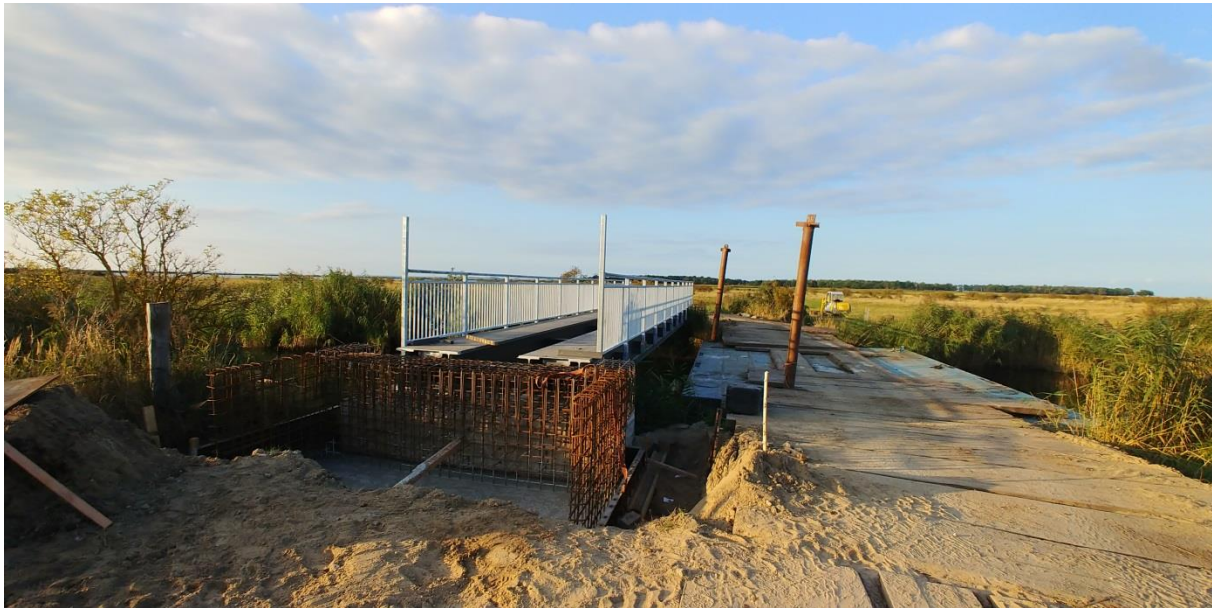
Abb. 4: Neubau Brücke zum Struck, Fundamentierung auf der Südseite, rechts Ponton; 14.09.2021.
