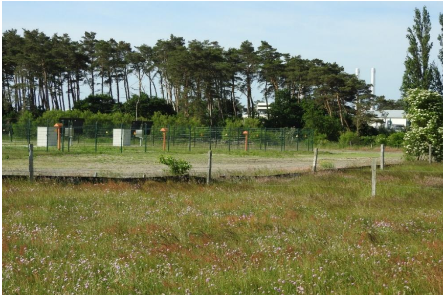
Bereich der Baugrube A der Netzanbindung (Fa. 50 Hertz) in den Freesendorfer Wiesen nach Abschluss der Bauarbeiten. Wartungsstraße im Hintergrund noch nicht fertiggestellt, 06.06.2024.
