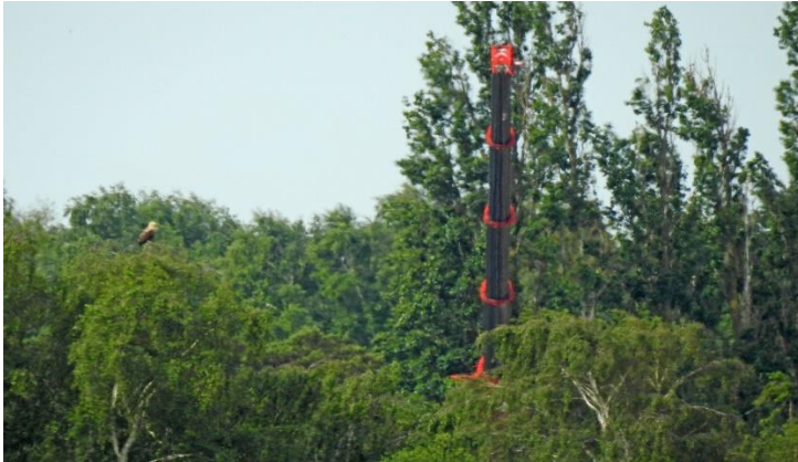
Abb. 6: Montagearbeiten an der Baugrube A (100 m Schutzzone des Seeadlerhorstes). Links im Bild der von den Arbeiten gestörte Seeadler in der Nähe seines Horstes, 19.06.2022.
