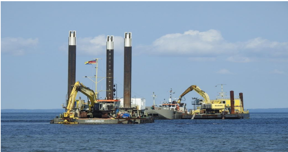
Abb. 7: Baggerarbeiten für Kabelverlegung im strandnahen Bereich vor Freesendorf, 31.07.2022
