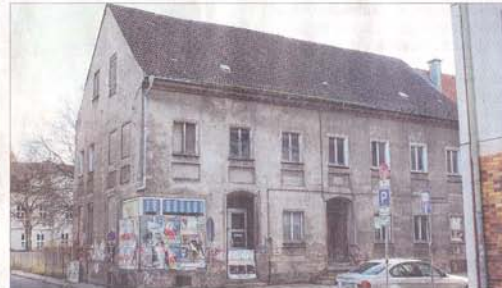
Die Steinbeckerstraße 35 verfällt. Das Wohnhaus des verdienstvollen Bürgermeisters Gesterding hat eine wertvolle Innenausstattung.
