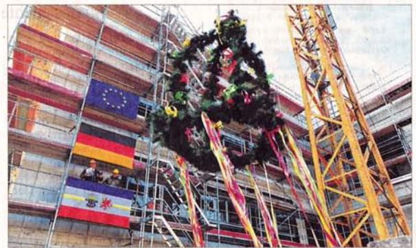
Per Kran wird die Richtkronen auf den Rohbau des neuen Labor- und Seminargebäudes in der Soldmannstraße gesetzt.
