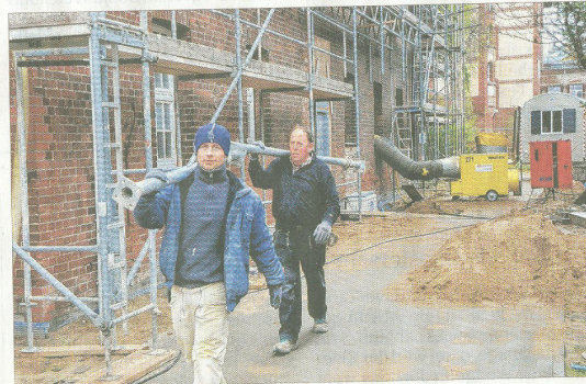
Gegenwärtig sind die Bauleute auch am Haupthaus an der Soldmannstraße aktiv. Es ist der erste Bauabschnitt. Foto: Peter Binder
